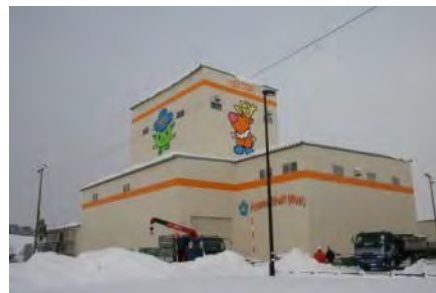
建屋完成(23年12月)
