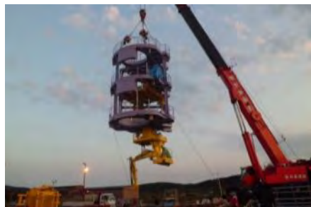
スcaffold投入(23年9月)
