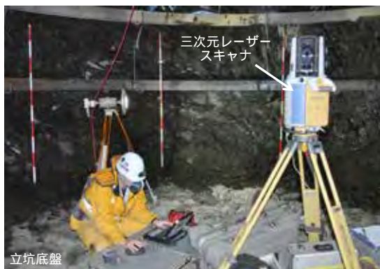
三次元レーザースキャナによる岩盤壁面の計測
