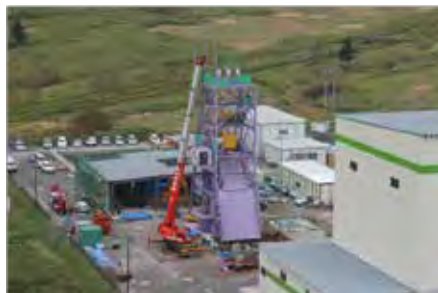
やぐら設備設置(23年10月)
