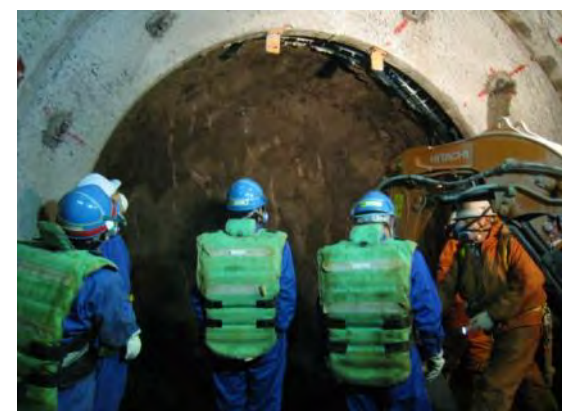
坑内パトロール (平成24年1月)
