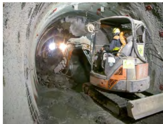
350m調査坑道掘削
