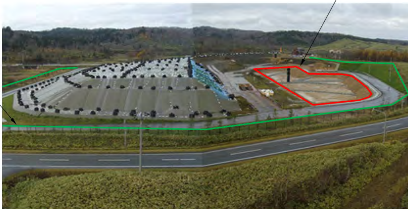
掘削土(ズリ)置場(23年11月)
