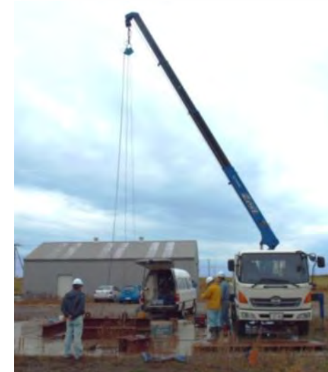
産業技術総合研究所-原子力機構 共同研究 既設ボーリング孔を用いた物理検層の様子 (平成23年10月、於浜里地区)
