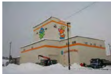
建屋完成(23年12月)
