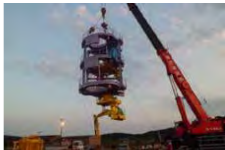
スcaffold投入(23年9月)
