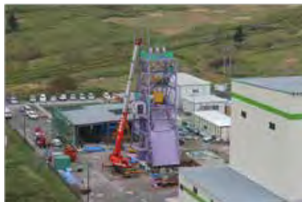
やぐら設備設置(23年10月)
