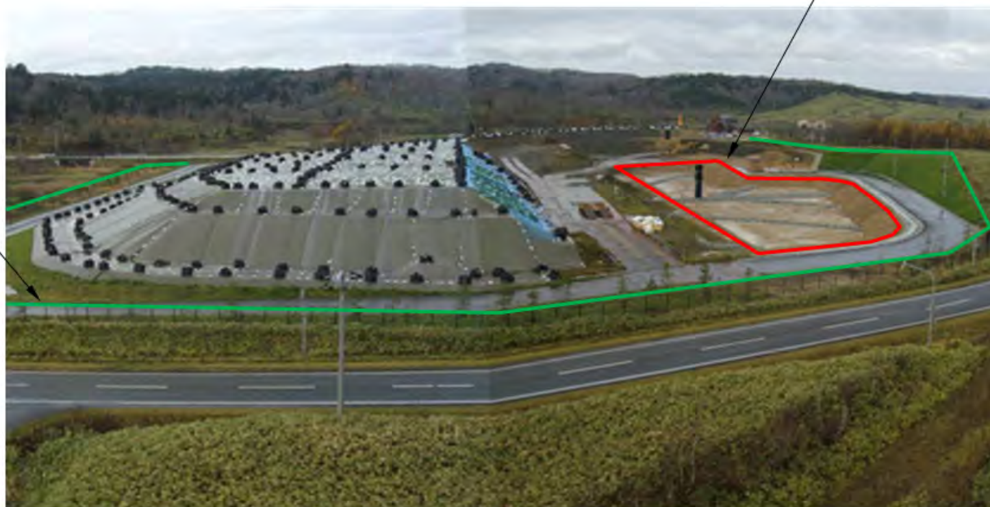
掘削土(ズリ)置場(23年11月)
