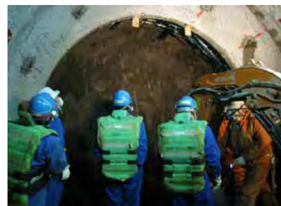
坑内パトロール (平成24年1月)
