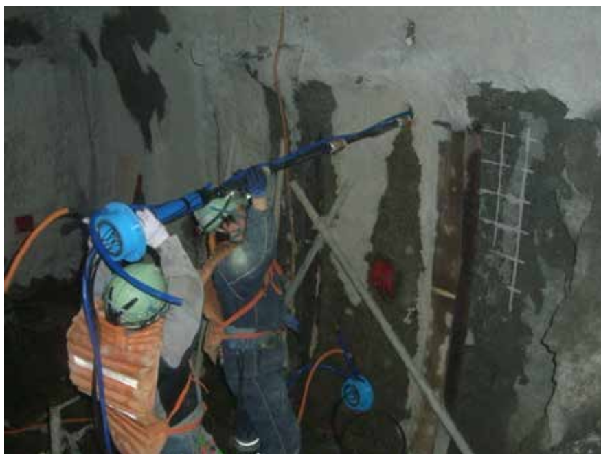
地中変位計の設置の様子（250m調査坑道）
