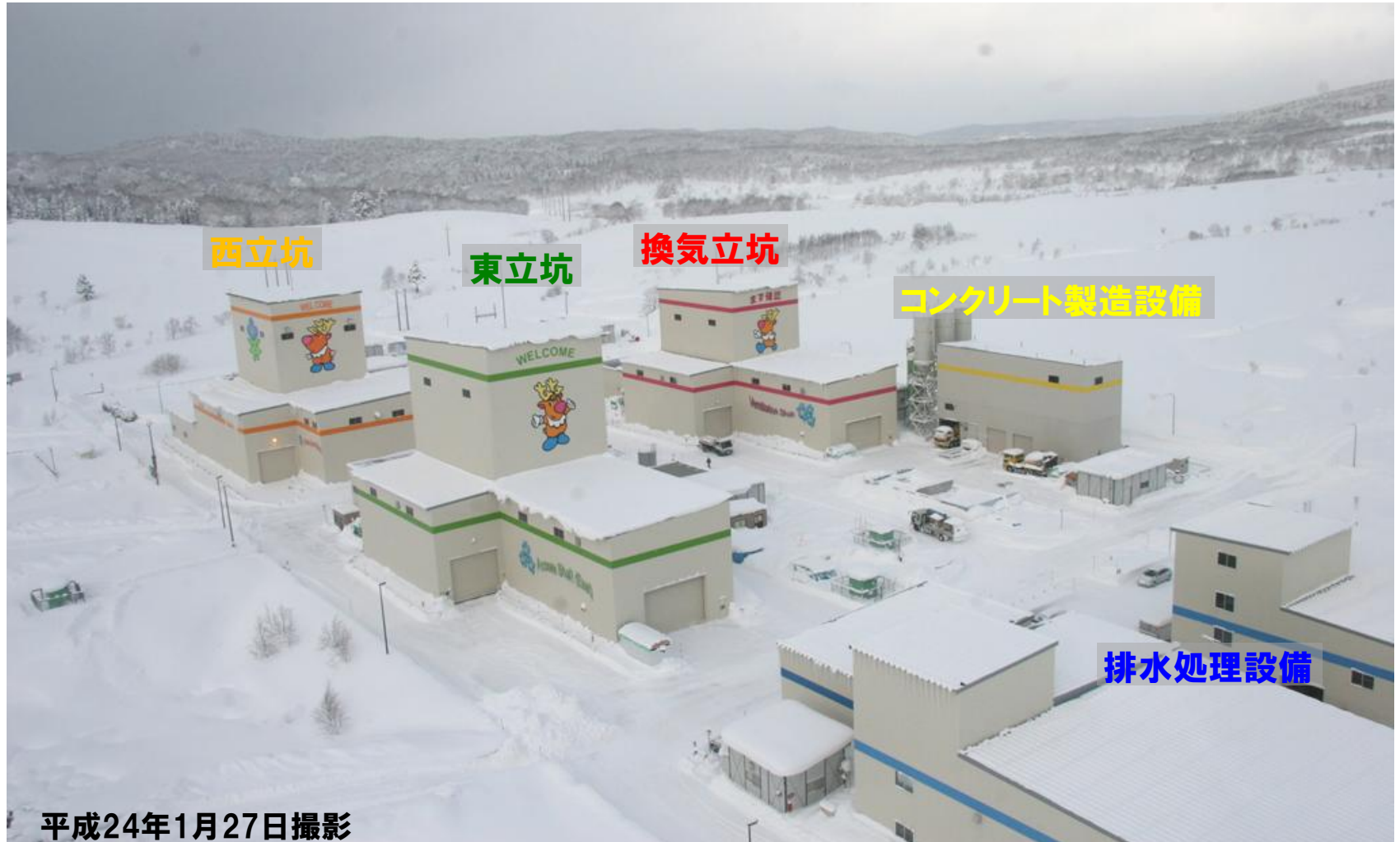
地下施設関連設備の現況
