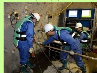
地層科学研究 (坑道掘削影響試験)
