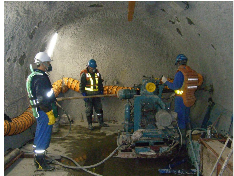
初期地圧測定のためのボーリング掘削の様子 (250m調査坑道)
