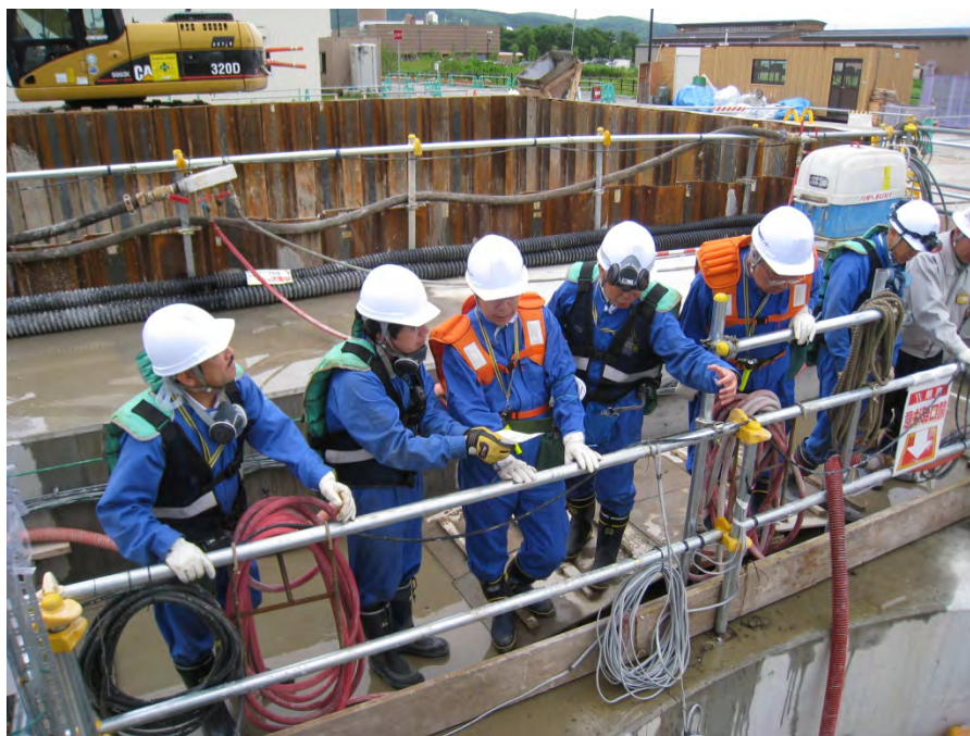
写真 7 安全パトロールの様子
