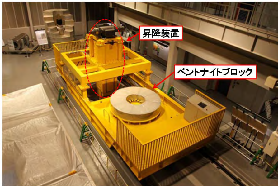
写真 2 緩衝材定置試験設備の製作状況
