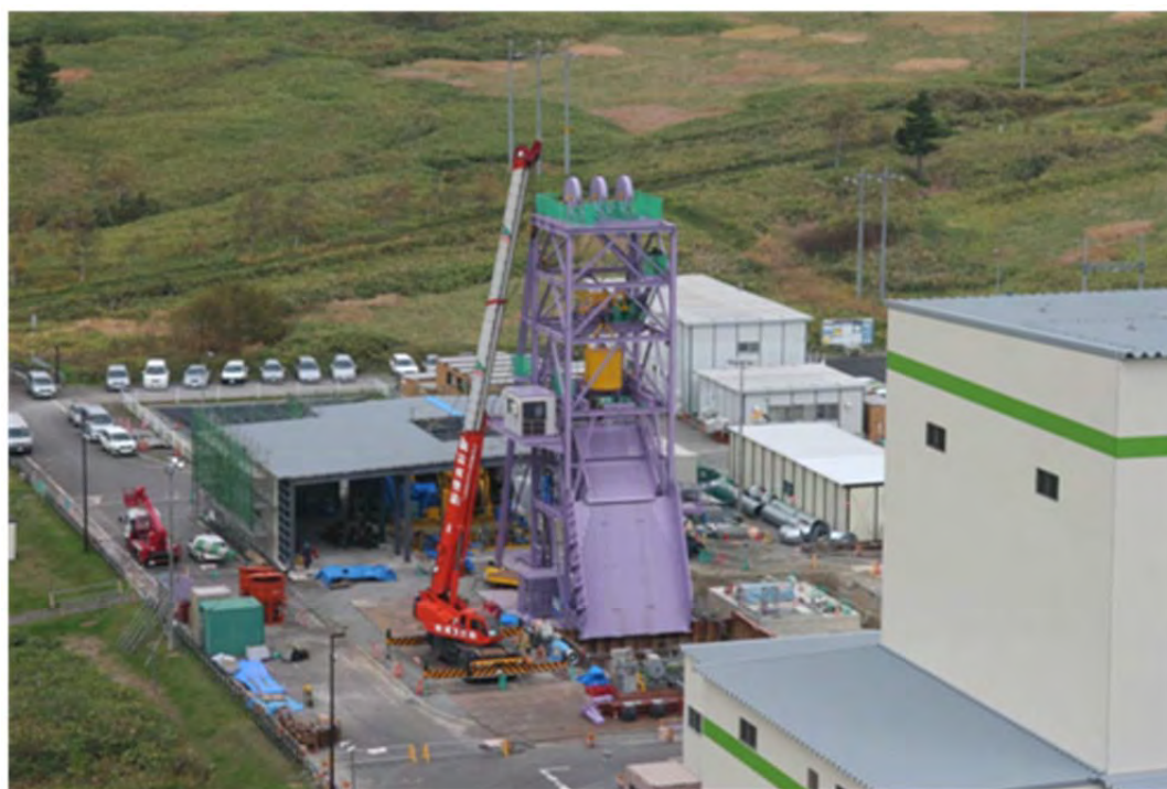
写真 5 西立坑のやぐら設備設置状況
