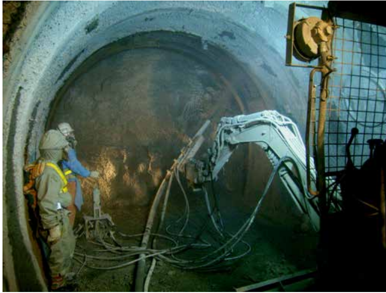
写真 1 施工試験実施状況
