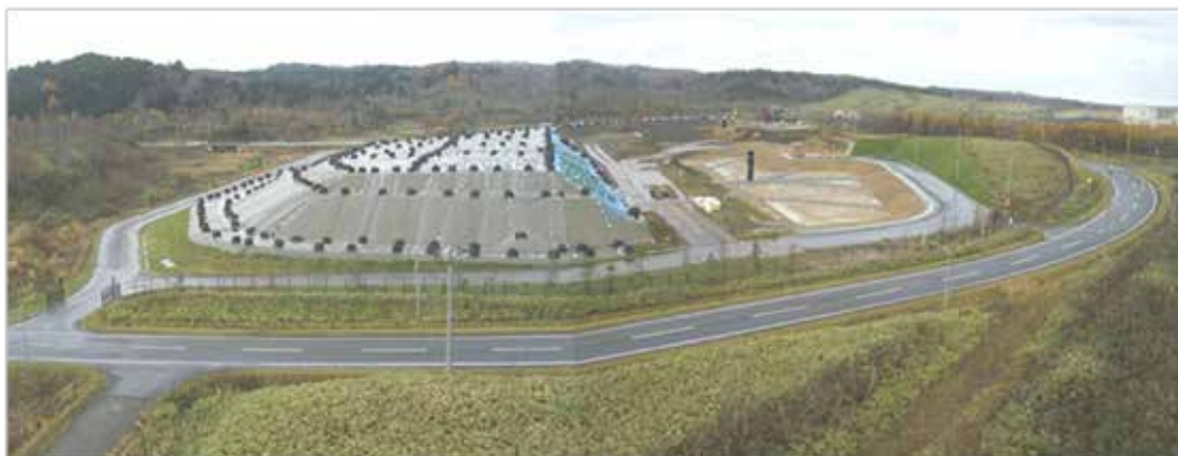
写真 6 掘削土(ズリ)置場の盛土および拡張整備状況
