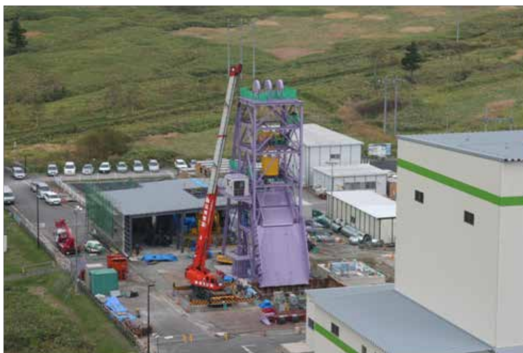
写真 5 西立坑のやぐら設備設置状況
