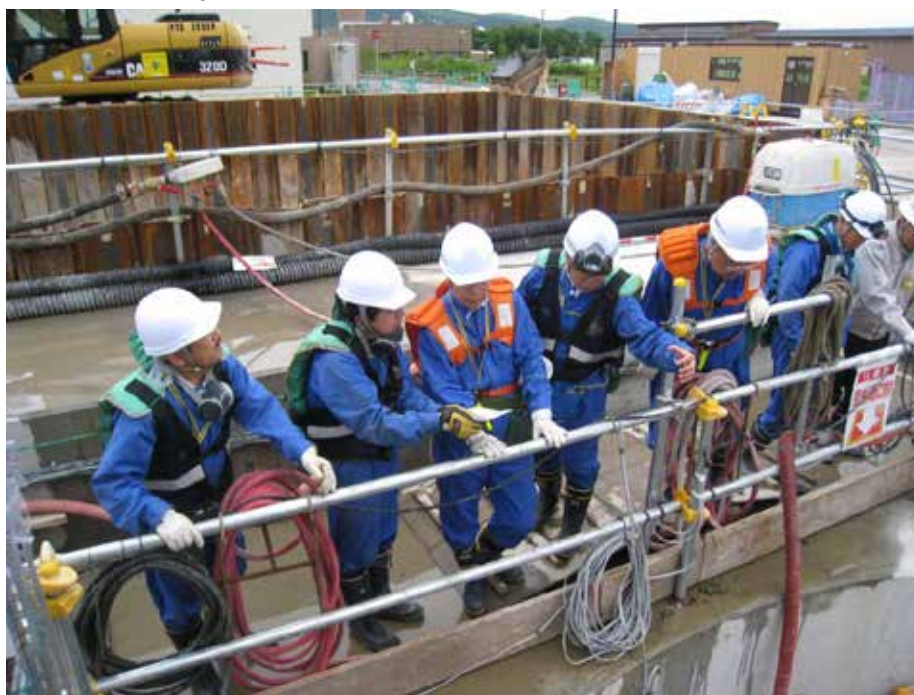
写真 7 安全パトロールの様子
