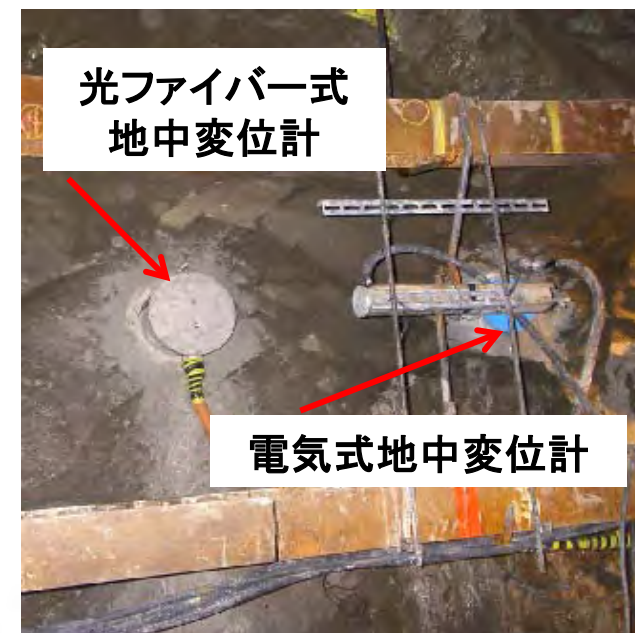
地中変位計の設置状況
