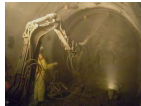
低アルカリ性コンクリート材料を用いた原位置施工試験
