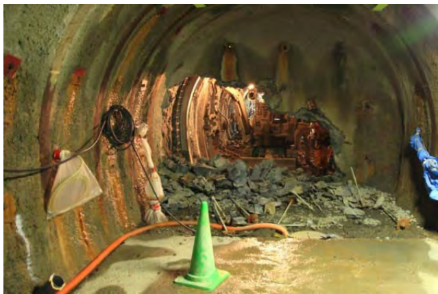
250m調査坑道貫通(22年6月)
