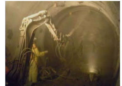
低アルカリ性コンクリート材料を用いた原位置施工試験
