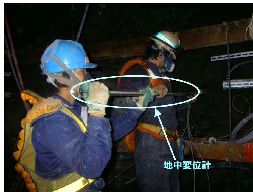
地中変位計設置状況 (東立坑深度160m)
