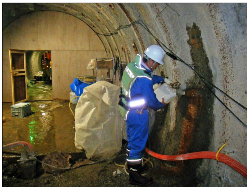
地下水採取の様子 (250m調査坑道)
