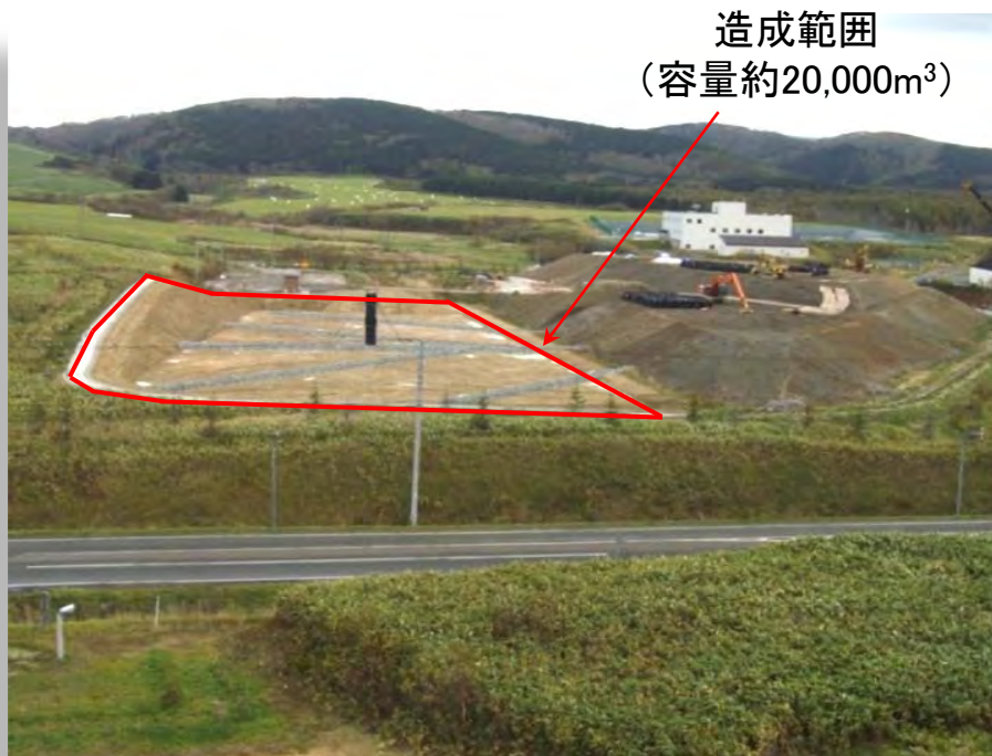
掘削土(ズリ)置場(22年10月)
