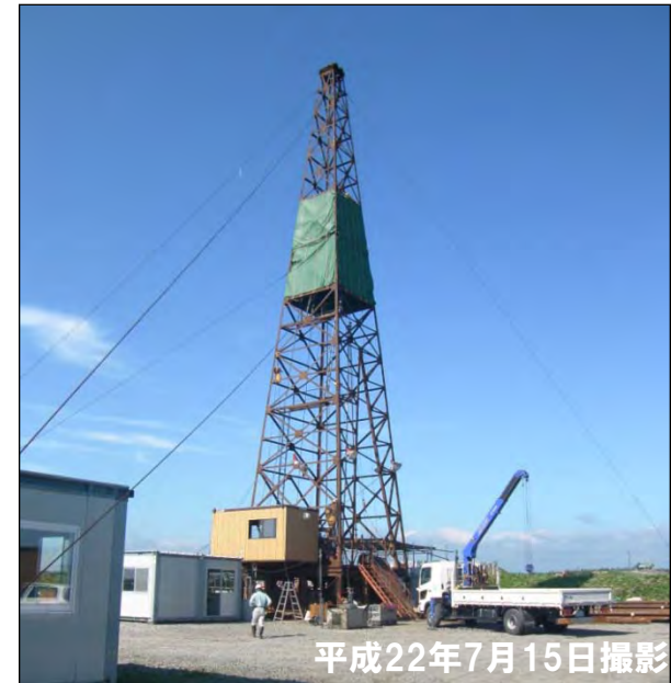
沿岸域を対象としたボーリング調査の様子 (浜里地区での調査:DD-1孔)
