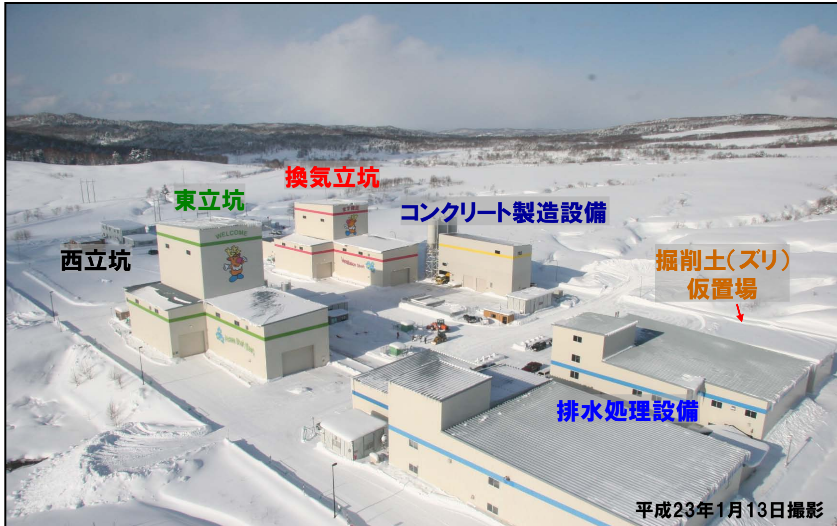
地下施設関連設備の現況
