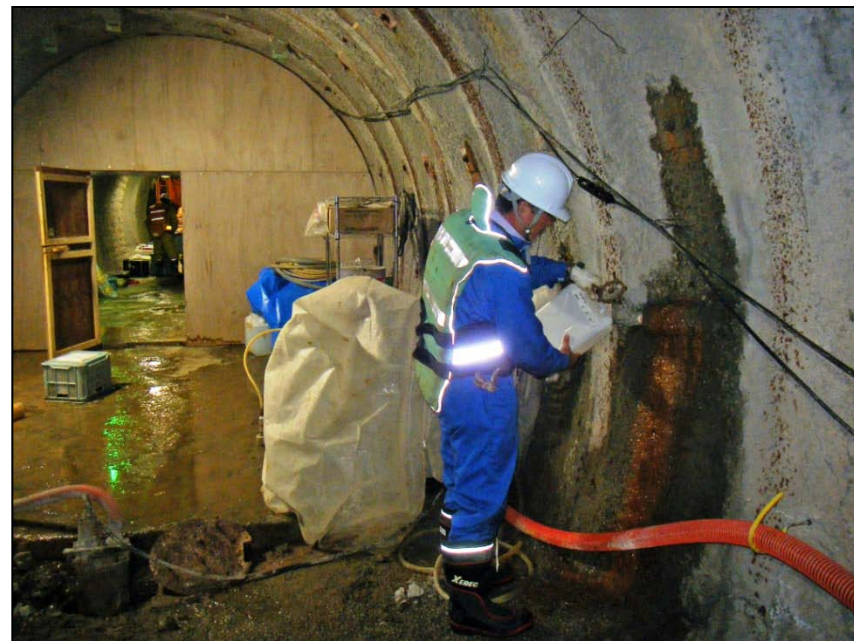
地下水採取の様子 (250m調査坑道)
