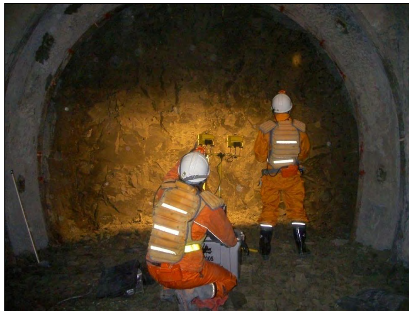
坑道壁面の地質観察の様子 (140m調査坑道)
