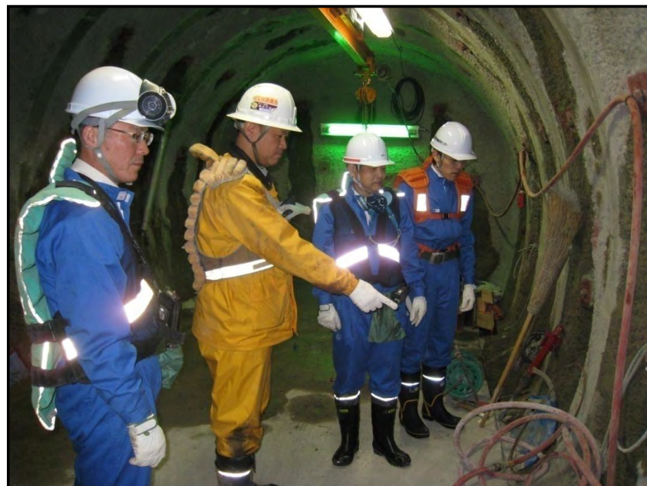
安全パトロールの様子 (平成22年度実施の例)
