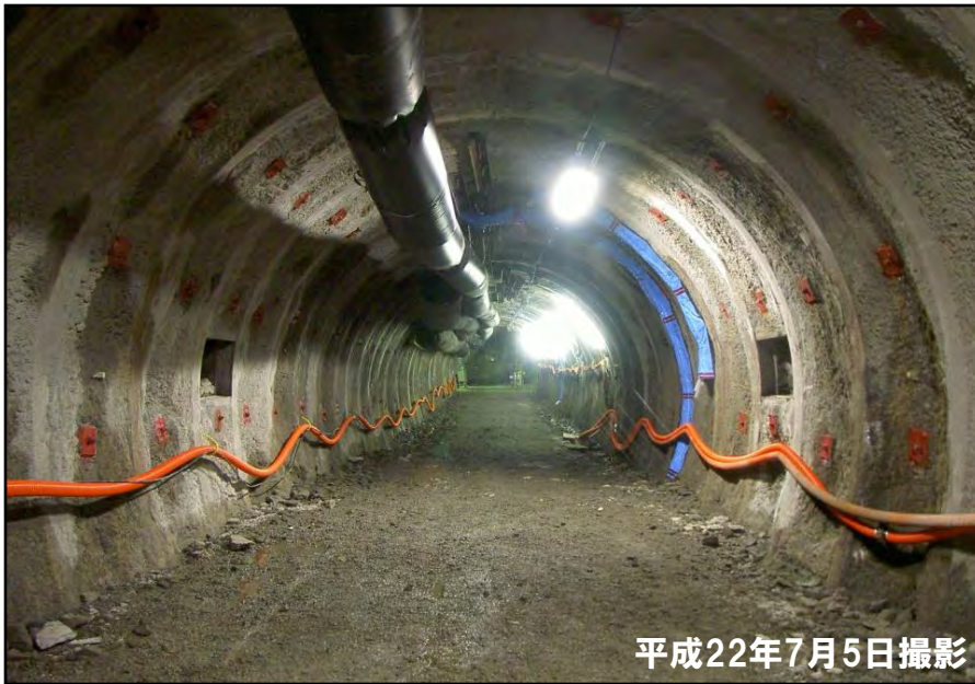
250m調査坑道の状況 (換気立坑側より東立坑側を望む)
