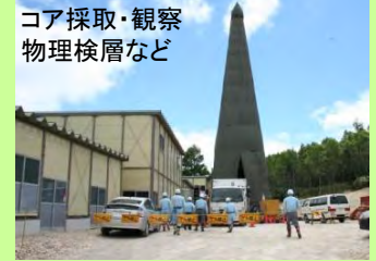
地層科学研究 (地上からのボーリング調査)
