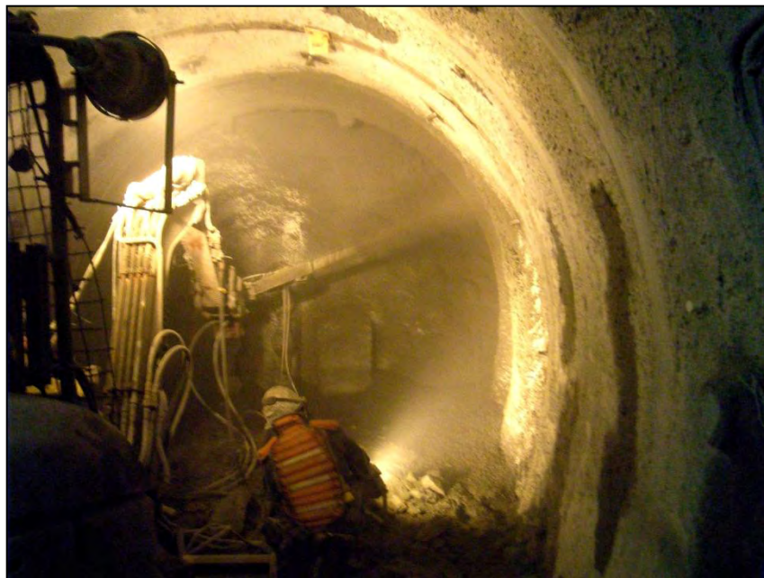
低アルカリ性コンクリート材料の吹付け状況 (140m調査坑道の例)
