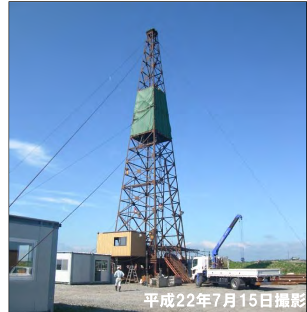
沿岸域を対象としたボーリング調査の様子 (浜里地区での調査: DD-1孔)
