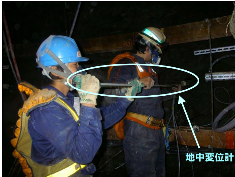
地中変位計設置状況 (東立坑深度160m)
