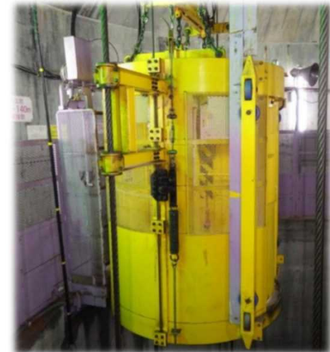
人キブル(工事用エレベーター)
