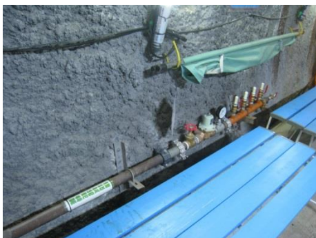
緊急用給気設備
