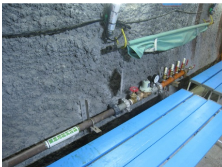
緊急用給気設備
