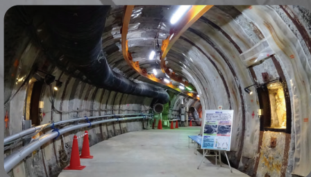
地下深くの坑道をご見学
