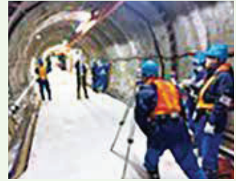
完成検査の様子 (500m調査坑道)
