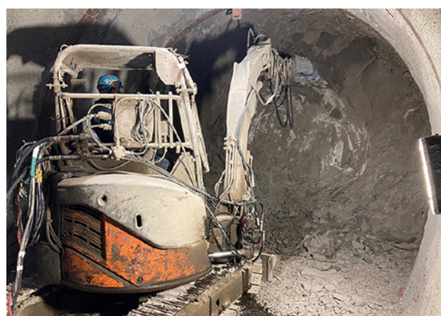
【500m 調査坑道の貫通】
