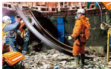
写真3 鋼製支保の設置
