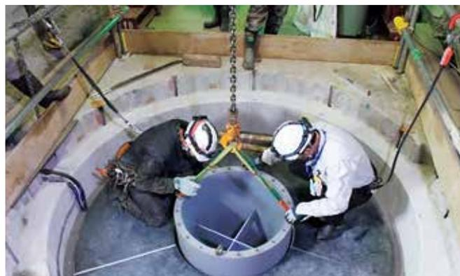
写真 模擬の人工バリアを設置している様子
