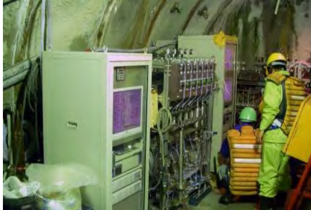
図 2-2 ボーリング孔に設置した観測装置による長期モニタリングの例
