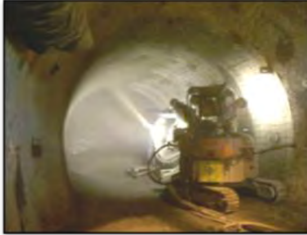
図 2-4 低アルカリ性コンクリート材料による坑道吹付け施工技術の実証 (幌延深地層研究センター深度 140m 調査坑道での施工例)
