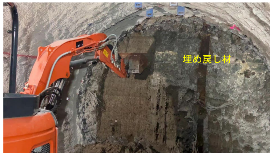
埋め戻し材の切削（ 動画はこちら ）
