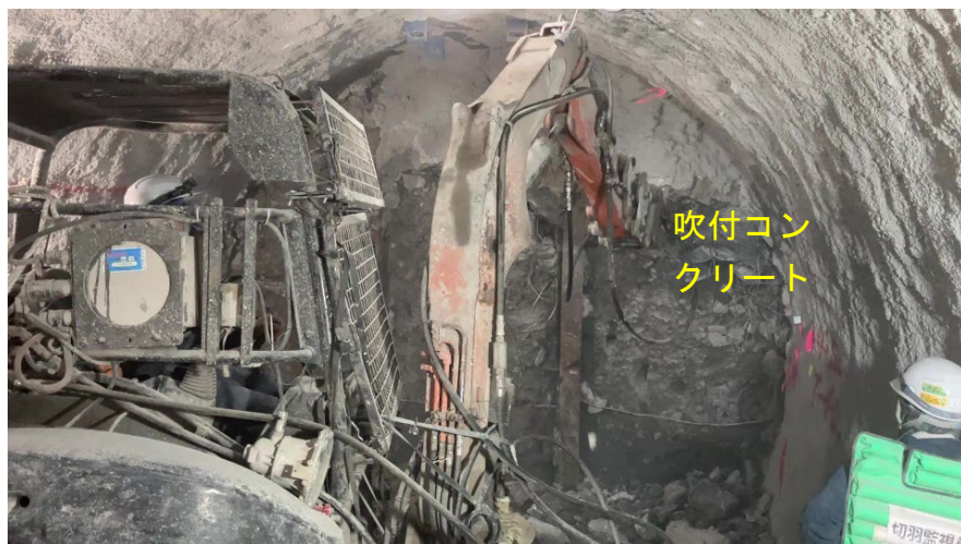
吹付コンクリートの掘削（ 動画はこちら ）
