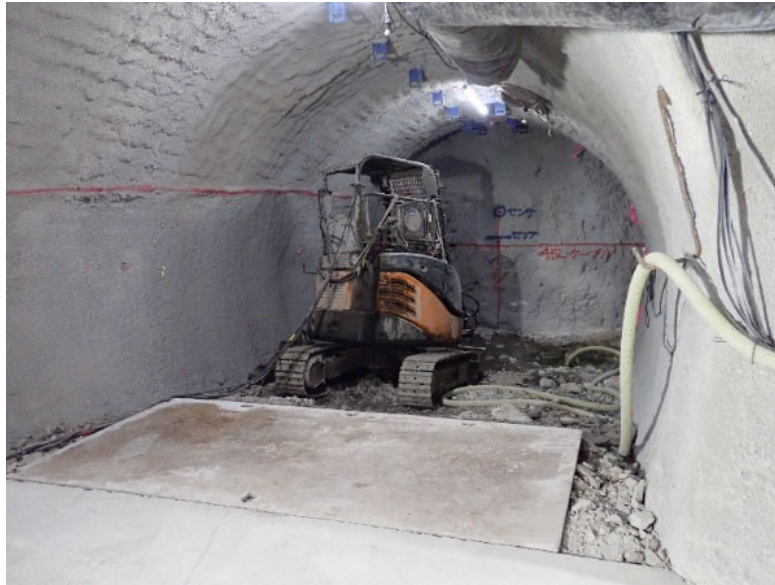
人工バリア性能確認試験（解体試験）での試験坑道掘削等の様子
