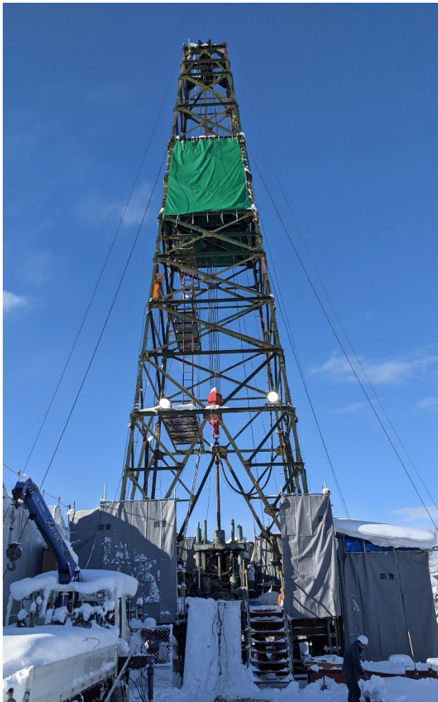
(a) ボーリング孔掘削の様子
