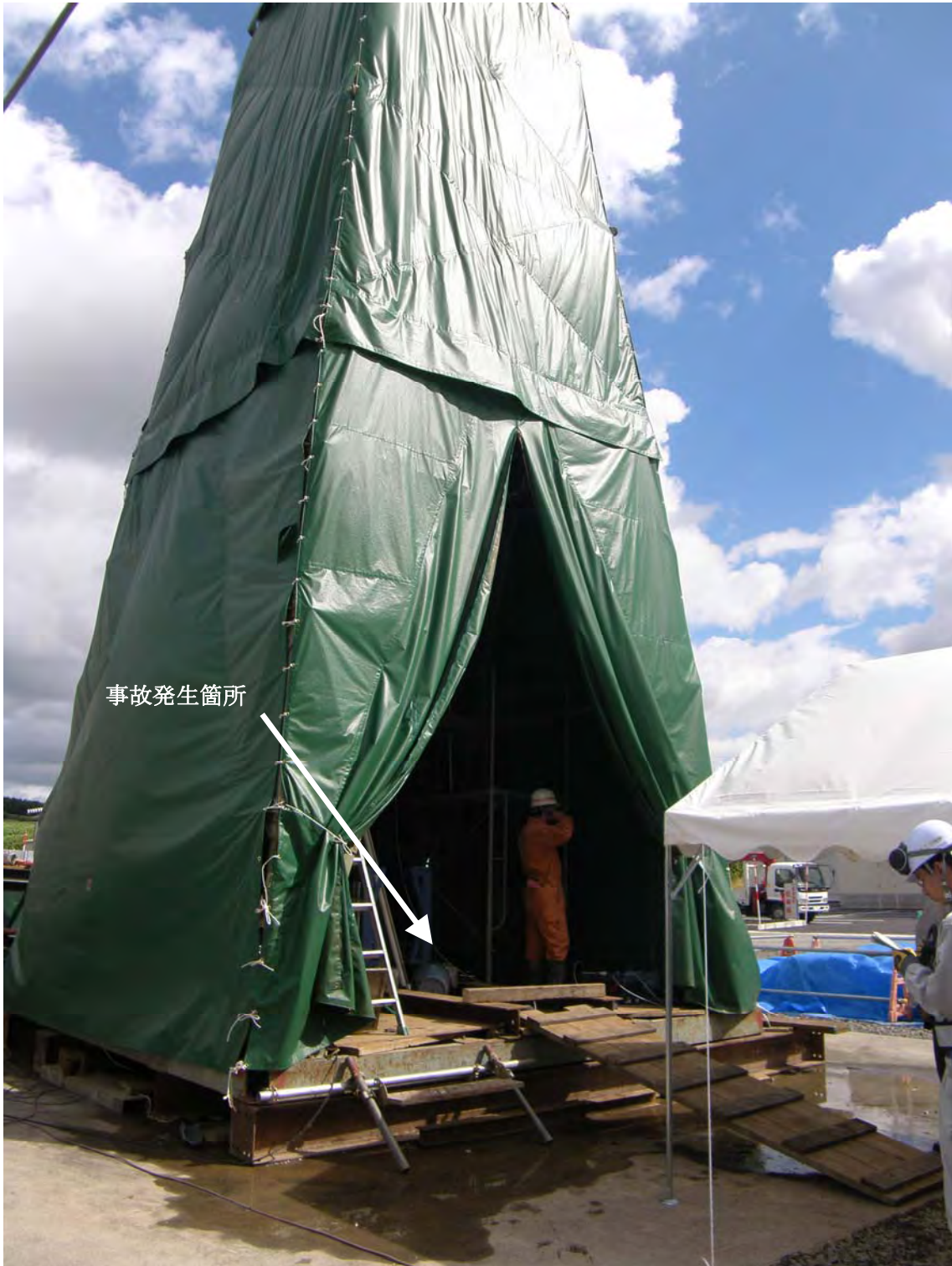
写真1 東立坑近傍ボーリング現場の全景写真
