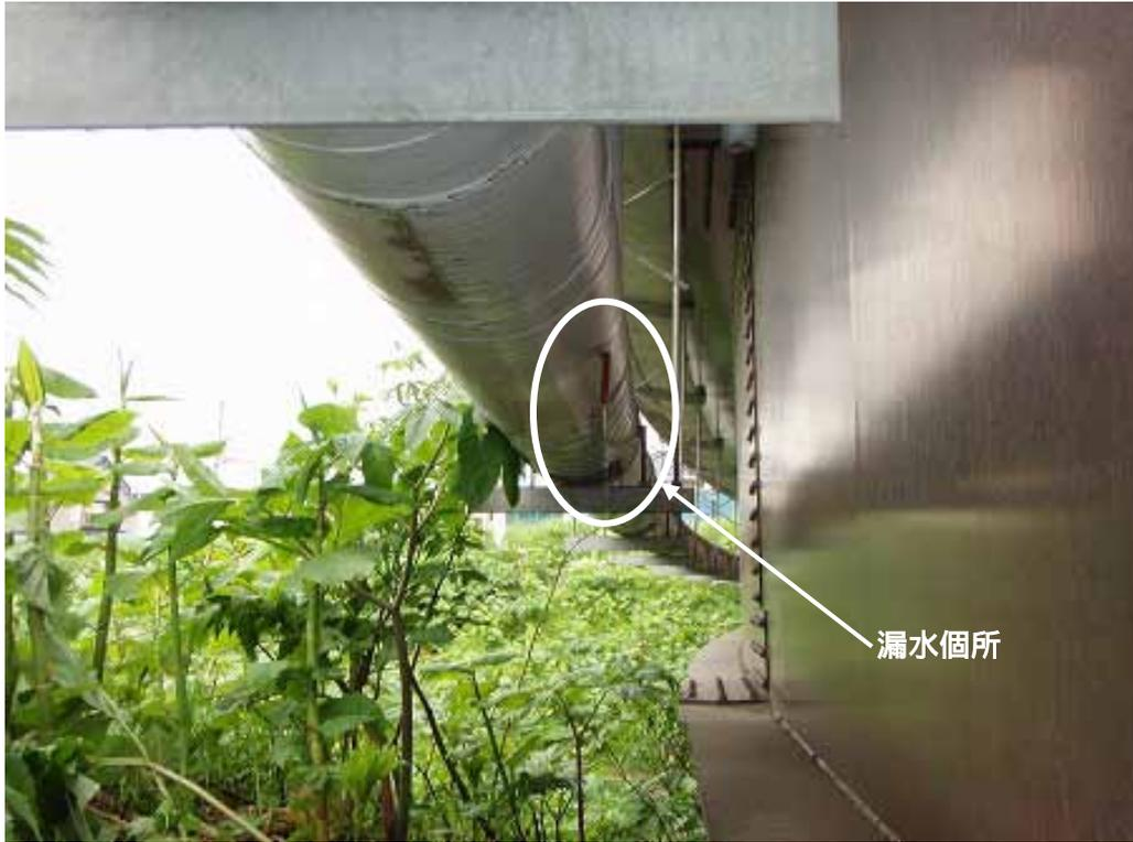
写真1. 排水管路からの漏水状況
