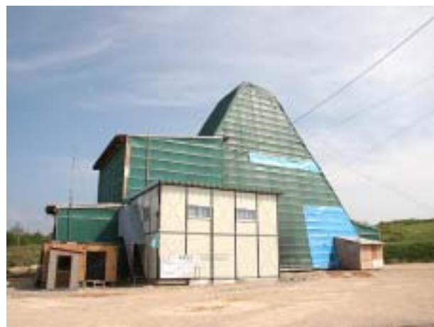
コントロールボーリング現場外観
