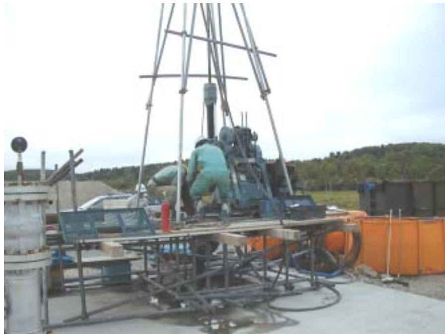
掘削作業風景
