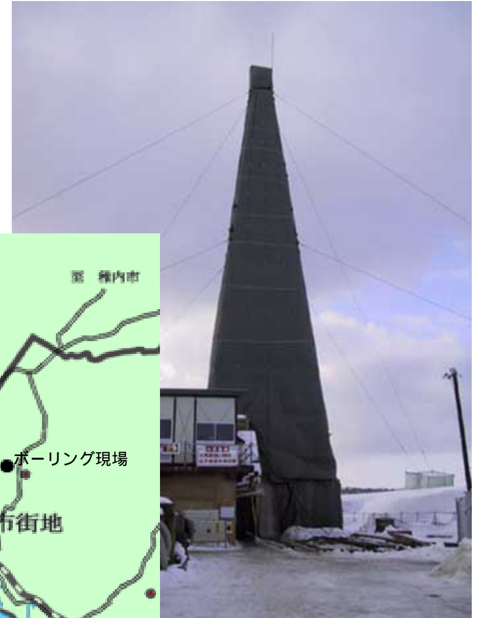
北進ボーリング現場
