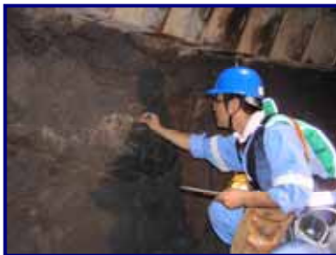
立坑壁面観察状況
