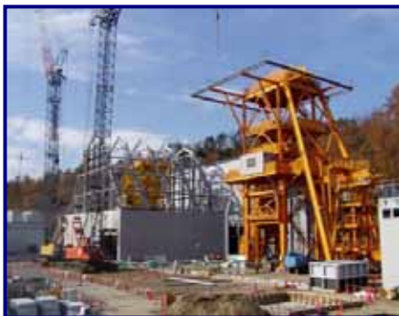
建設工事状況
