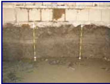
立坑壁面状況
