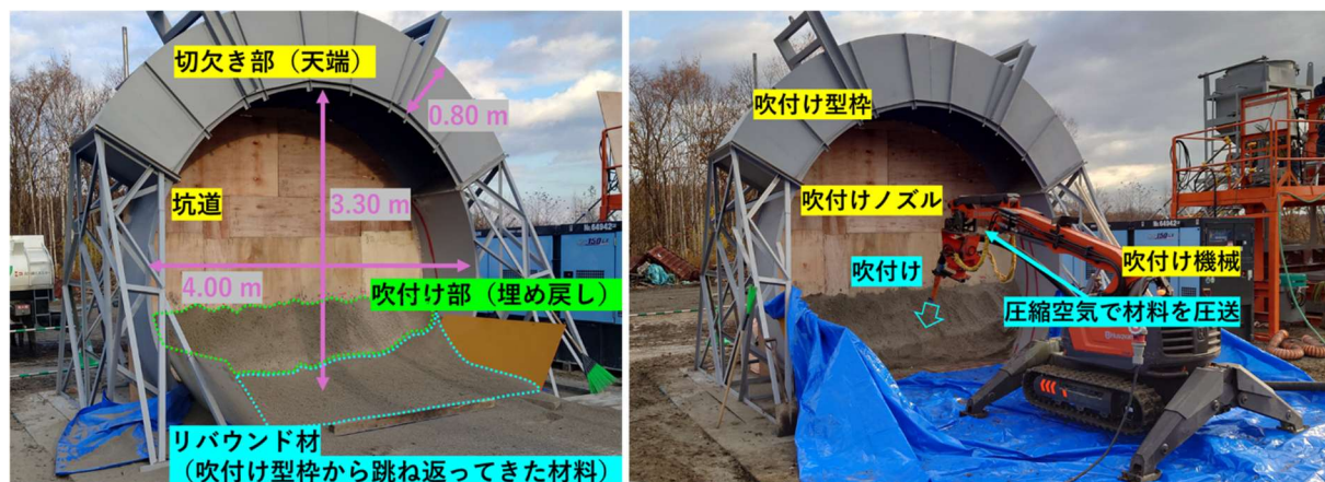
図 23 地上吹付け試験の実施状況
