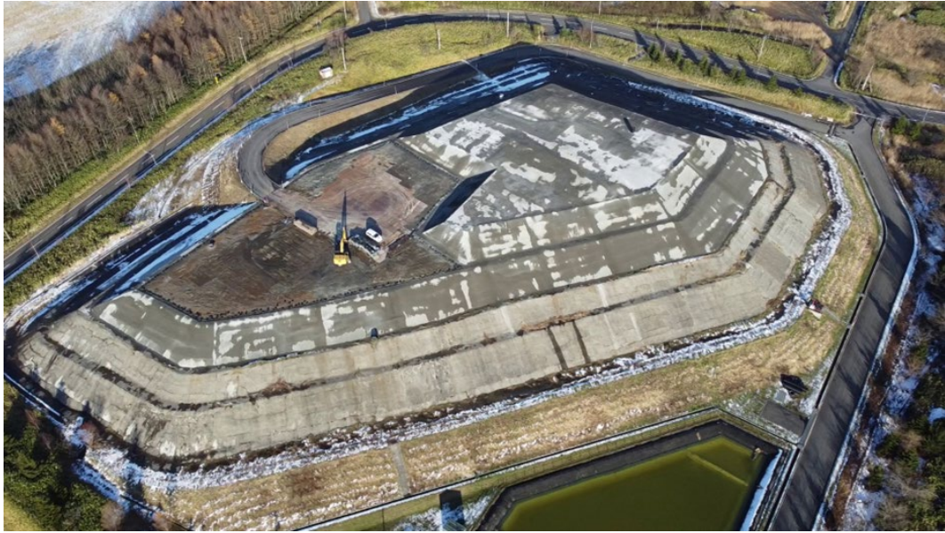
掘削土（ズリ）置場の吹付け作業完了後の様子
