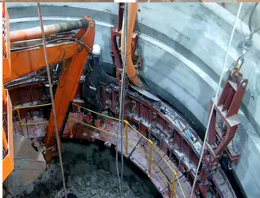
立坑掘削 (令和5年9月～令和7年6月)
