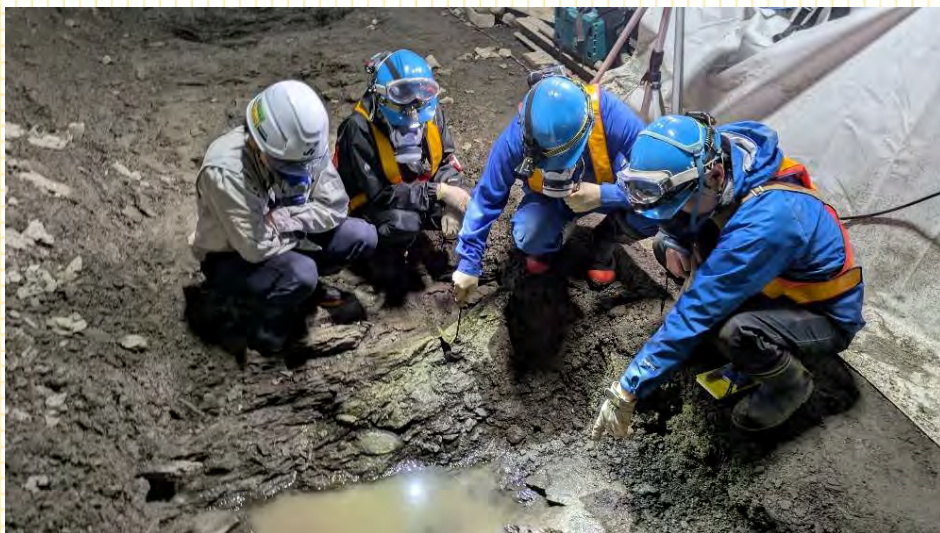
500m調査坑道での 湧水状況の観察
