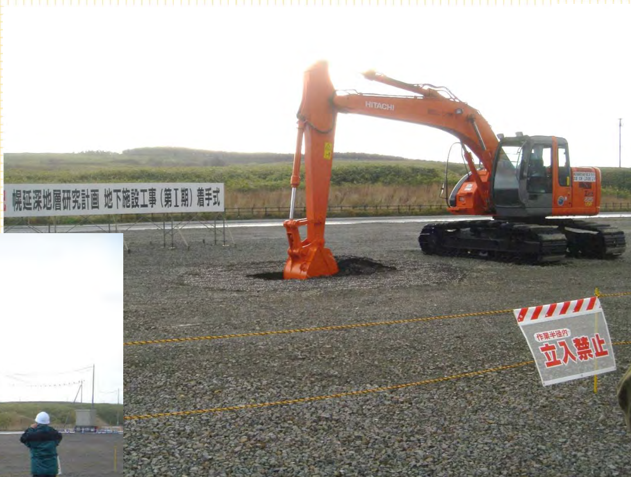
地下施設整備工事 着工 （平成17年11月）
