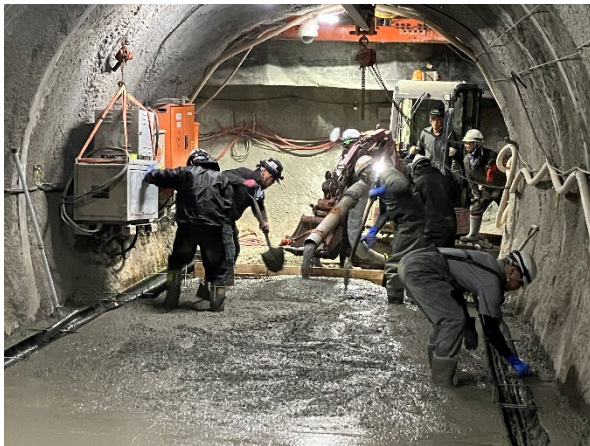
(a) 仕上げ（路盤整備）作業状況
