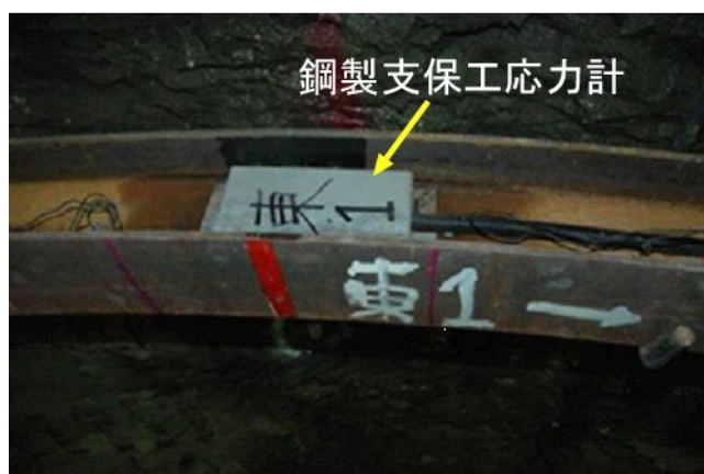
図 63 鋼製支保工応力計設置例
