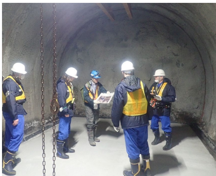
図 88 合同タスク会合での現地確認の様子(500m 調査坑道)
