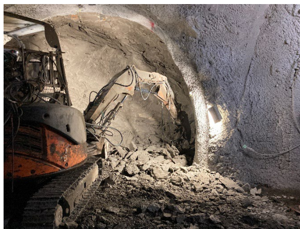
(b) 500m調査坑道の掘削状況
