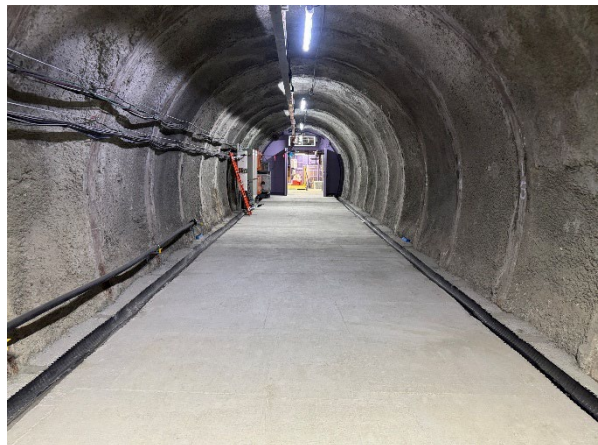
(d) 500m 調査坑道の完成状況
