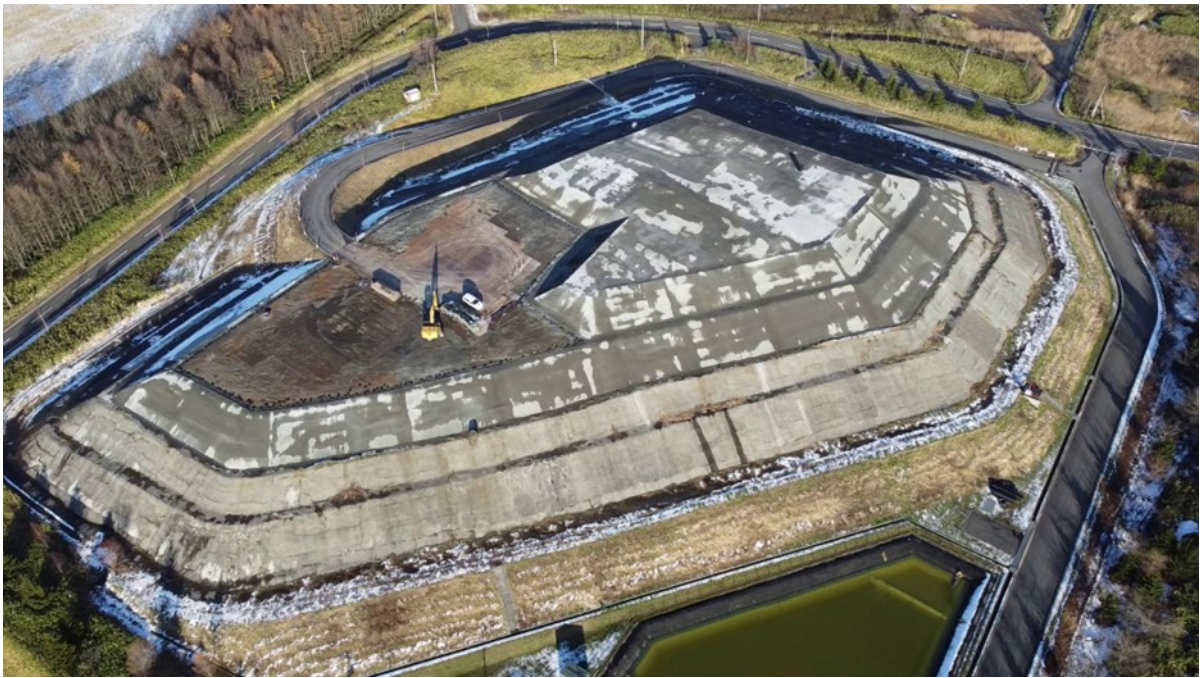
図 73 掘削土（ズリ）置場の吹付け作業完了後の様子
