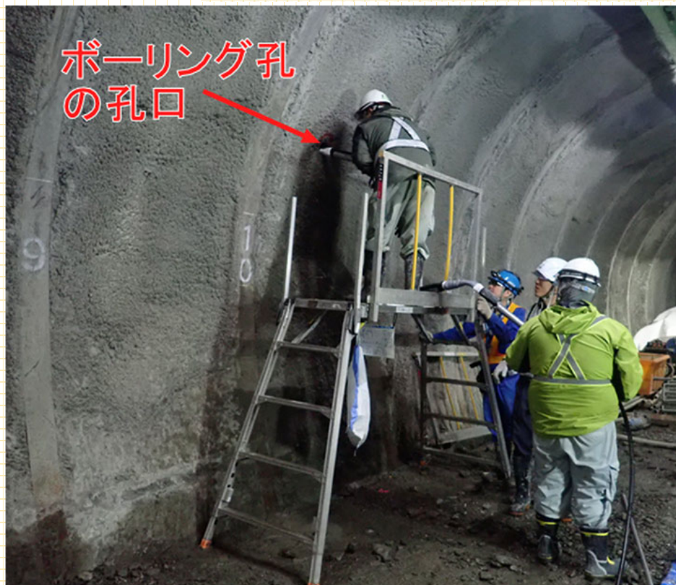
調査機器をボーリング孔に挿入している様子
