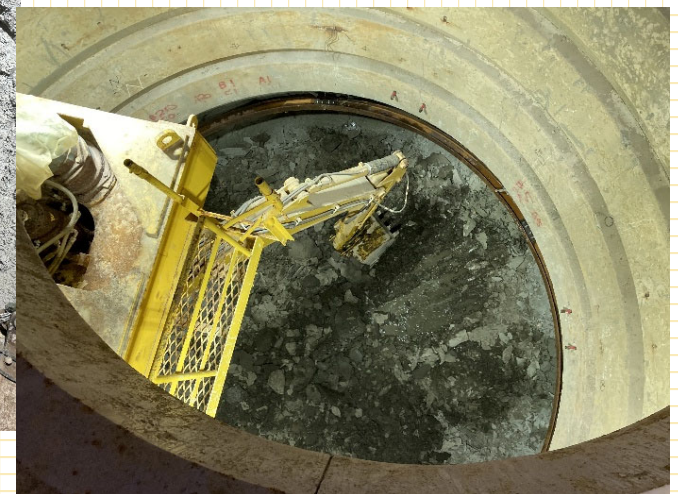
西立坑掘削状況
