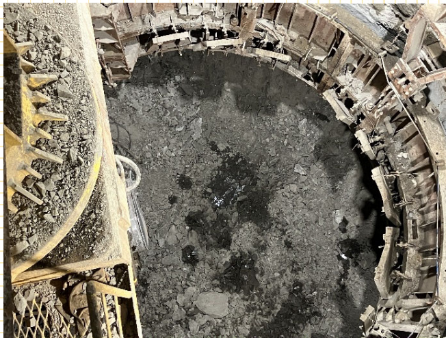
換気立坑深度500m到達時
