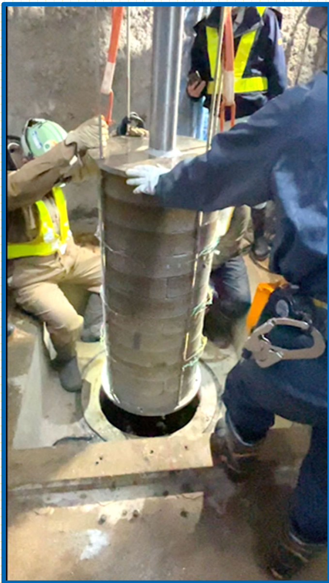
試験体設置時 (令和6年1月29日)
