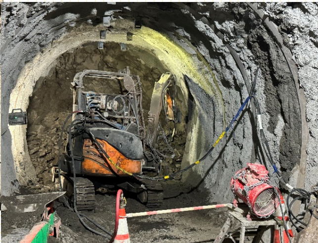
500m調査坑道の掘削状況
