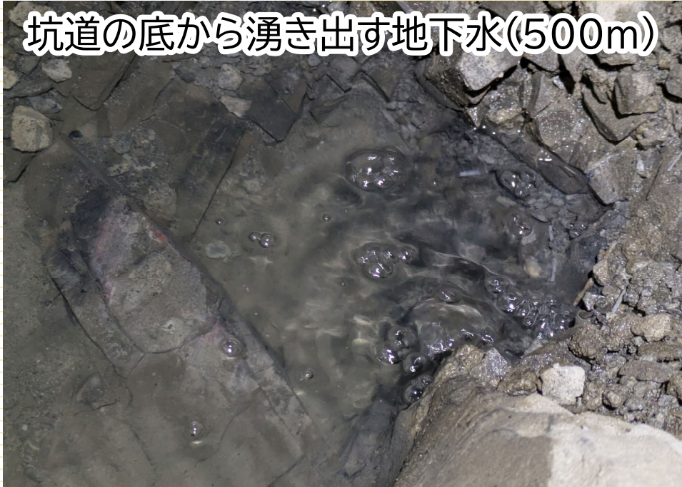
亀裂からしみ出る地下水(500m)
