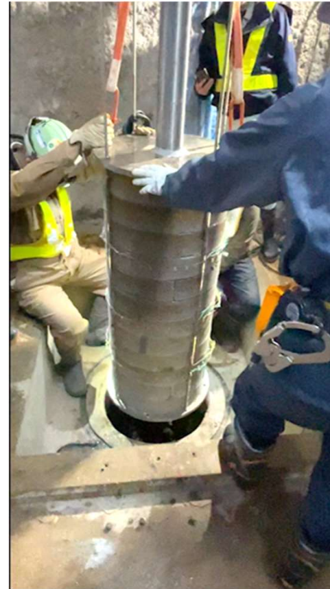
試験体設置時 (令和6年1月29日)
