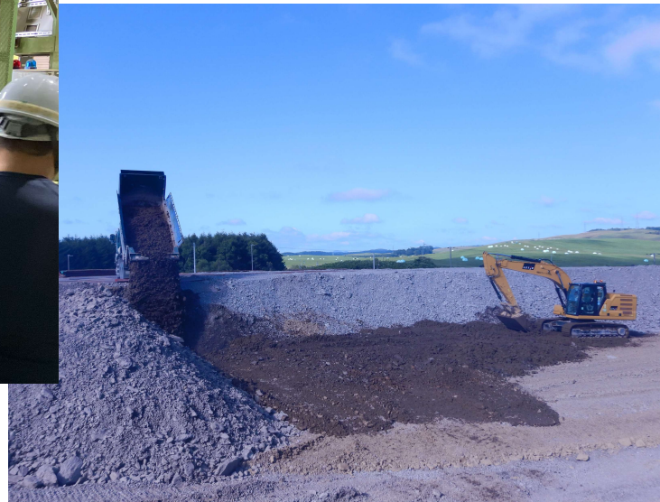
掘削土(ズリ)置場への 掘削土(ズリ)搬入の様子
