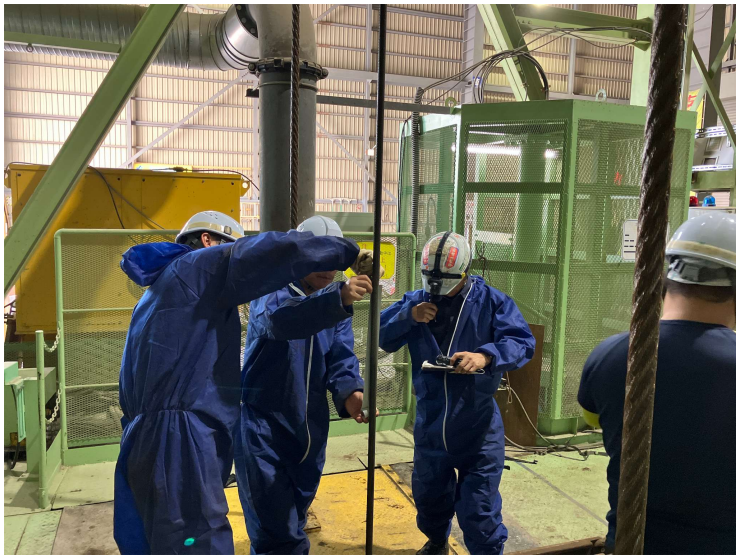
槽設備の点検
