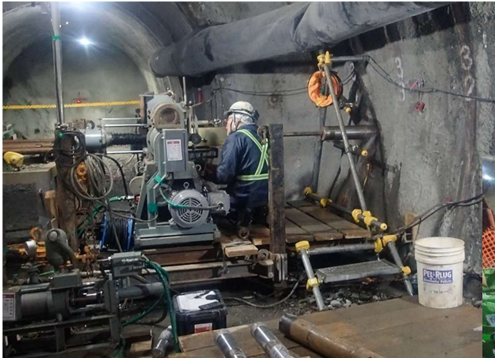
先行ボーリング掘削の様子
