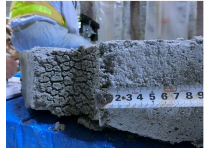
緩衝材ブロックのひび割れ
