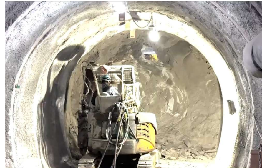
東連絡坑道の貫通
