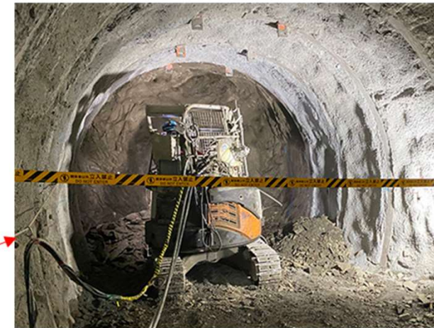
試験坑道7の掘削の様子
