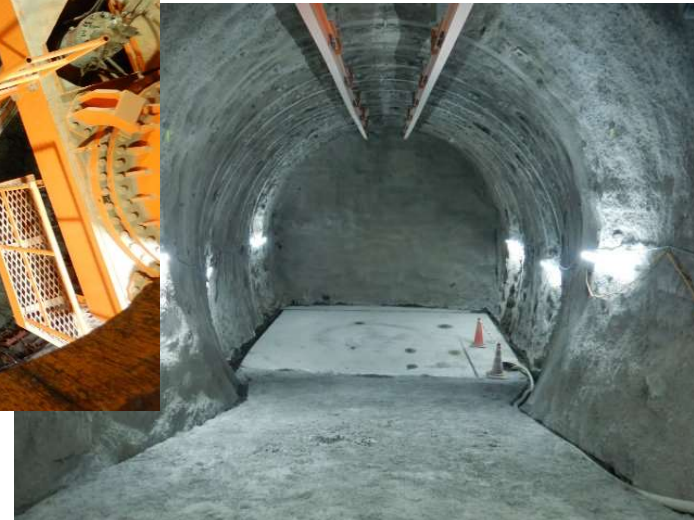
東立坑側第1ボーリング横坑
