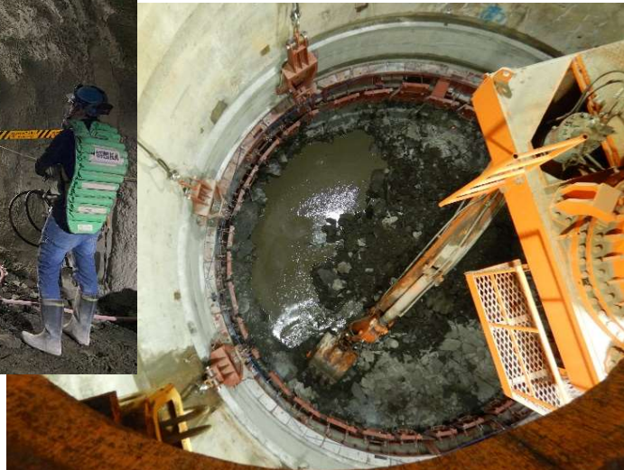
東立坑掘削状況
