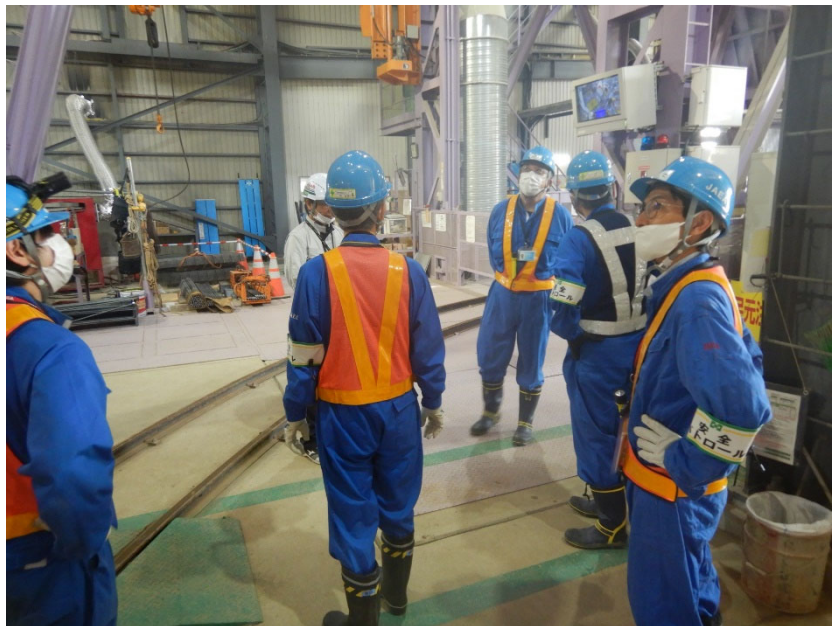
図 36 安全パトロールの様子
