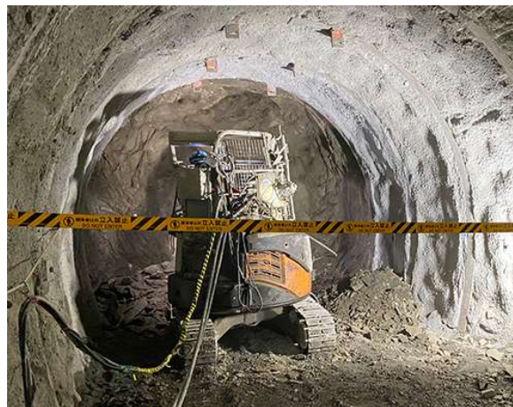
(b) 掘削の様子
