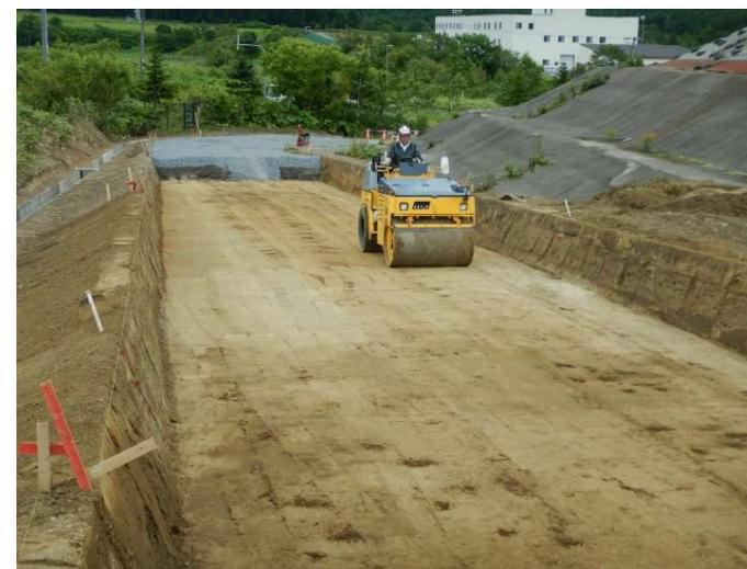
掘削土(ズリ)置場搬入用道路の造成工事の様子
