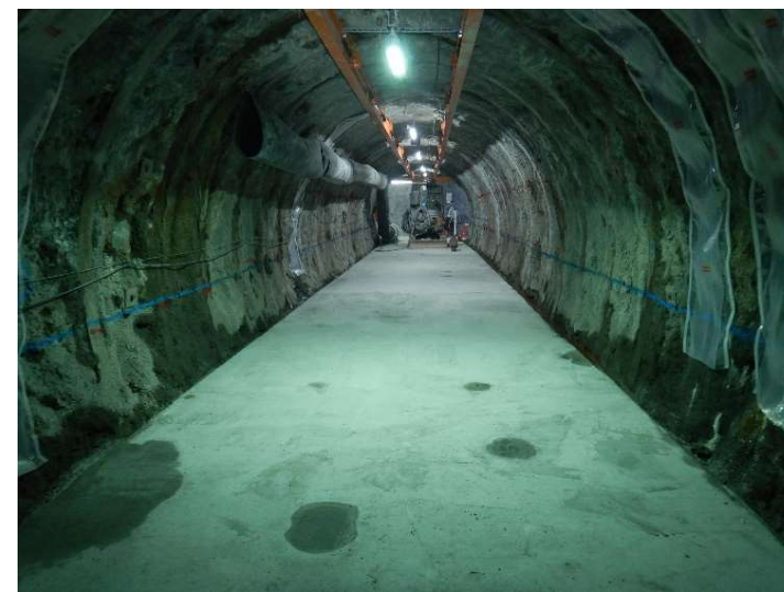
350m試験坑道6整備完了状況
