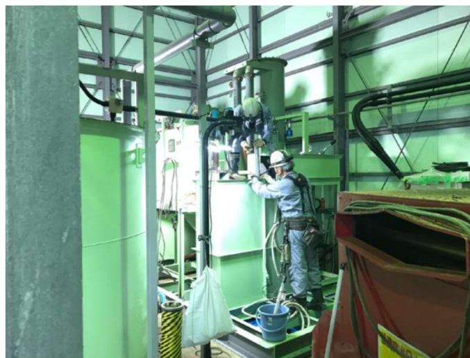
濁水処理設備の更新
