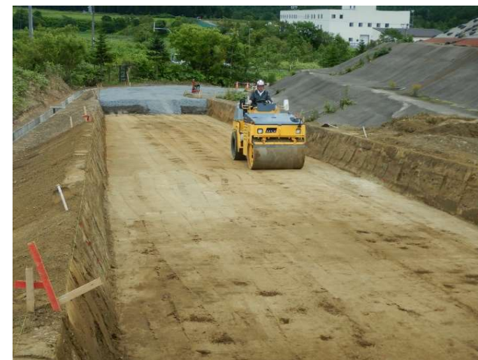
掘削土(ズリ)置場搬入用道路 の造成工事の様子
