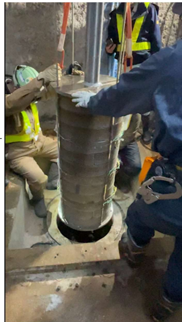
試験体設置の様子
