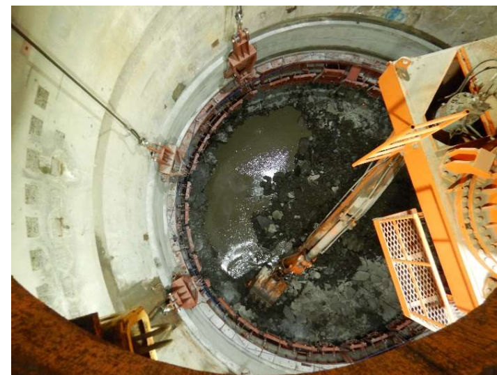
東立坑の掘削状況
