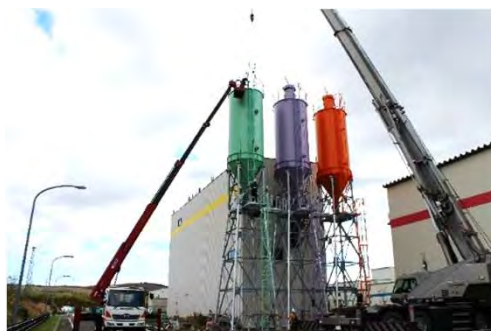
セメントサイロの設置
