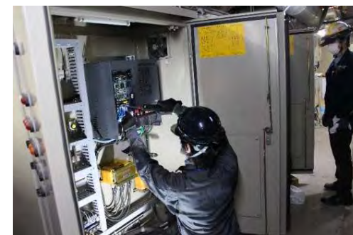
排水設備の更新
