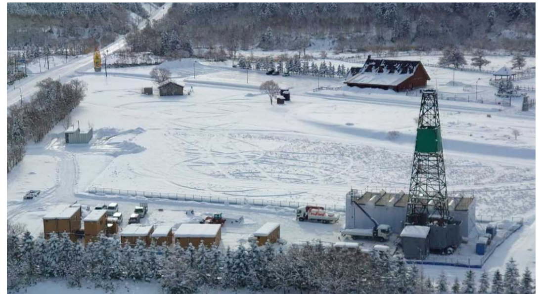
ボーリング調査現場の全景
