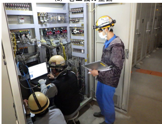
(b) 制御盤の整備
