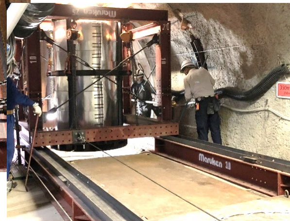
模擬オーバーパックの一体取り出しの状況
