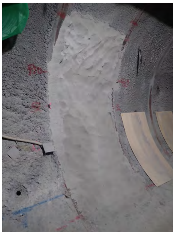
(c) 切欠き部の吹付け完了
