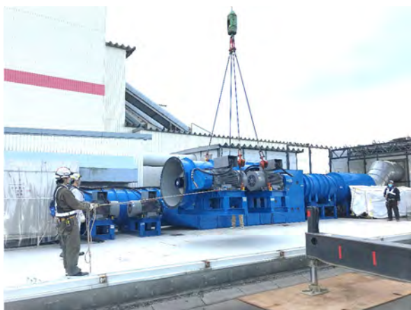
(a) 坑内換気設備の更新
