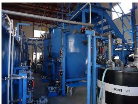
(a) 硝酸性窒素処理設備
