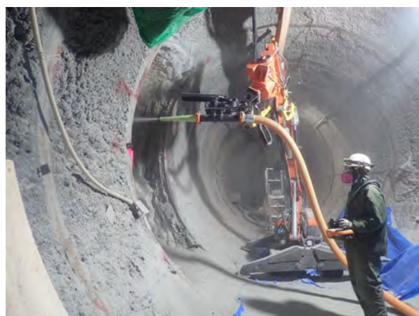
(a) 吹付け作業の状況
