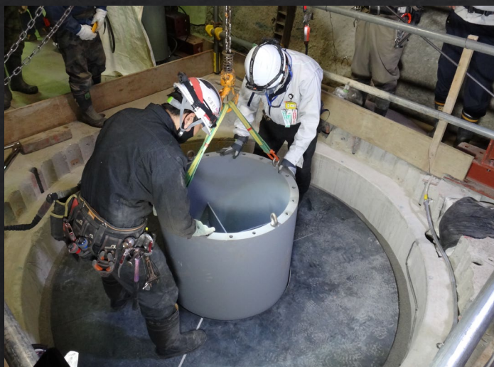
試験施工で使用する試験体の設置状況
