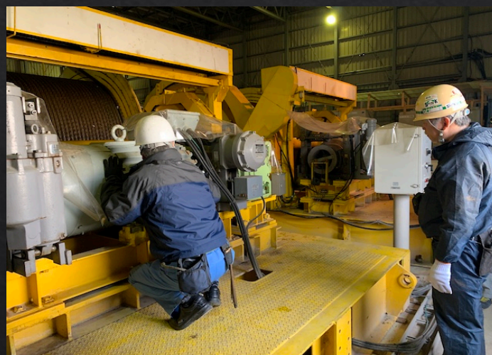
地下施設の維持管理状況 (スcaffold巻上機の点検)
