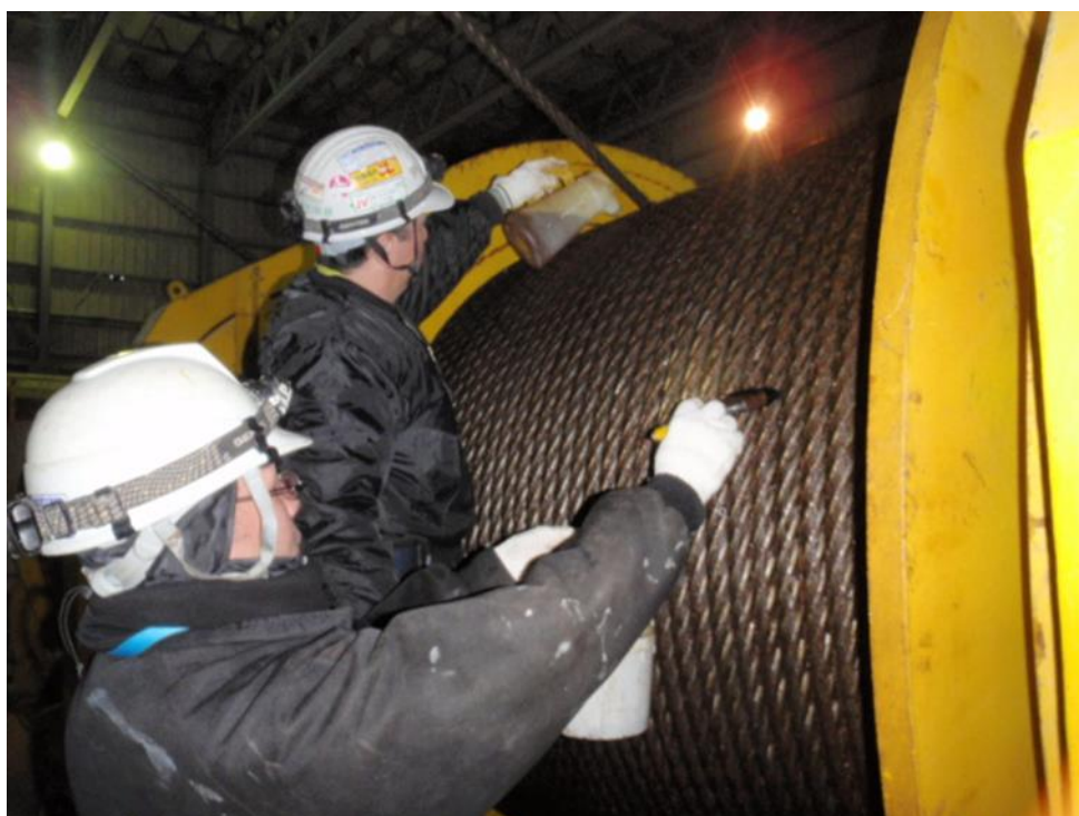
機械設備の維持管理の様子
