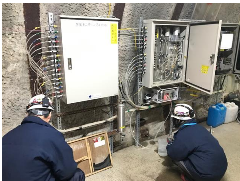
地下水の水圧・水質連続モニタリングの様子 （深度350m調査坑道）
