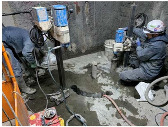
(a) スリットの掘削
