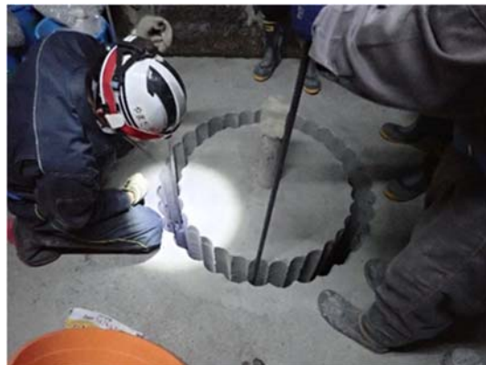
(c) 人力による突き固め
