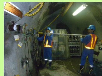
地層科学研究 (坑道掘削影響試験)
