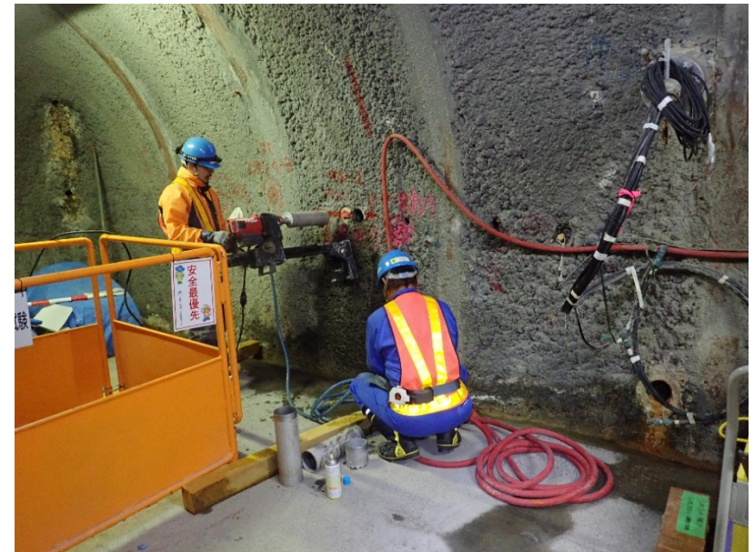
岩石試料採取の様子 (深度350m調査坑道)
