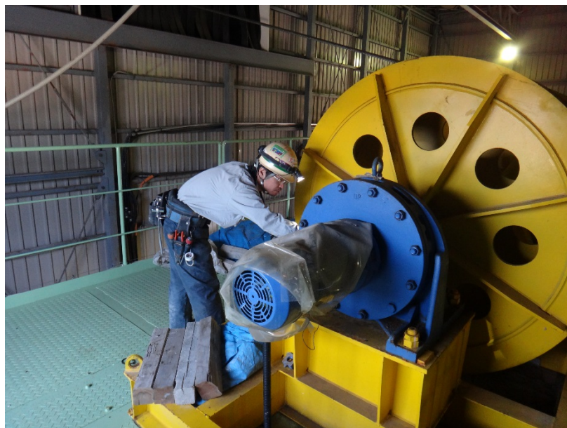
機械設備の維持管理の様子
