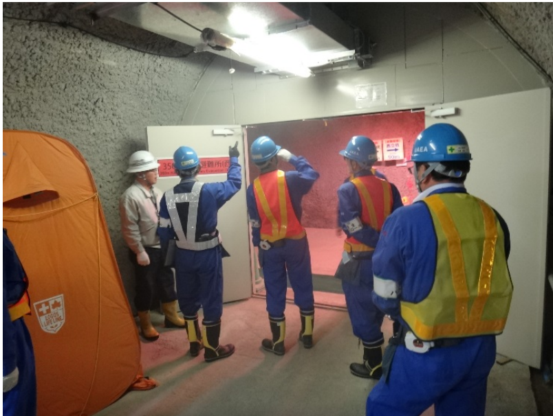
安全パトロールの様子
