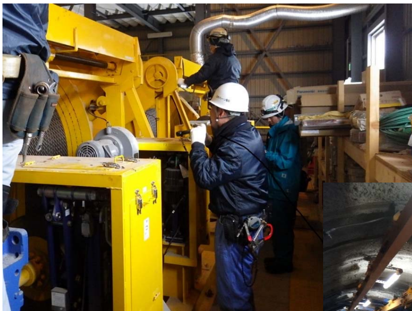
機械設備の点検・整備
