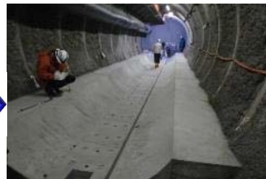
コンクリート台座の設置作業(組立台)
