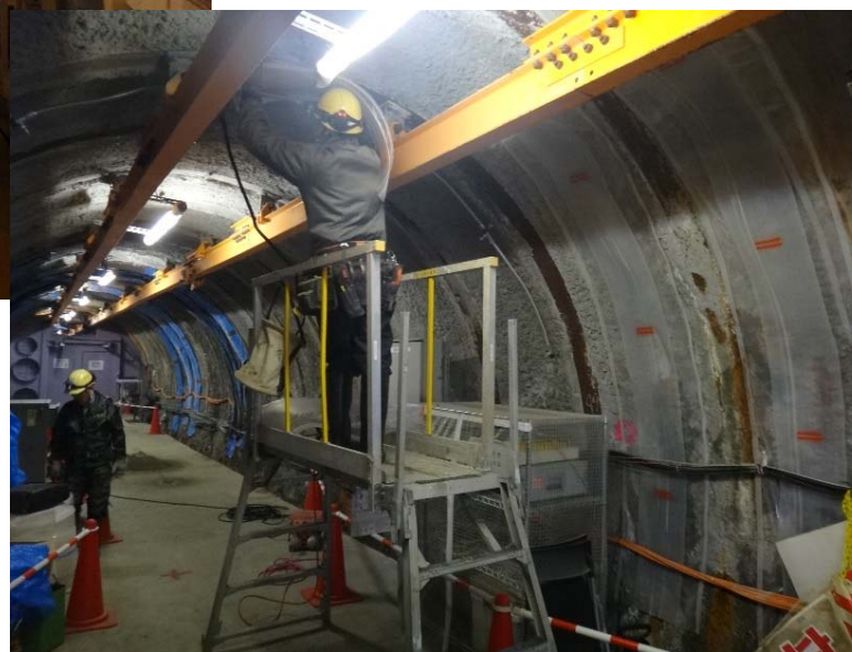
地下水の排水用シートの更新
