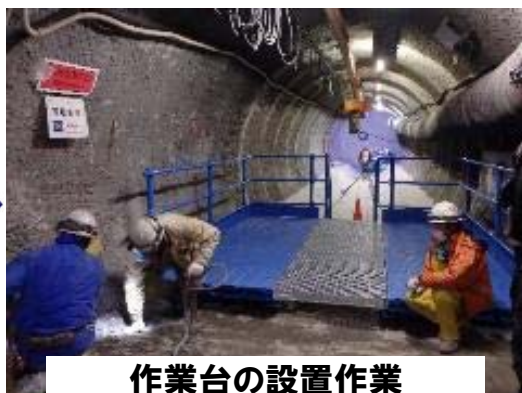
鋼製型枠の設置(組立台)
