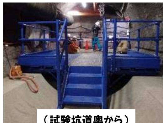
コンクリート台座の設置作業(組立台)
