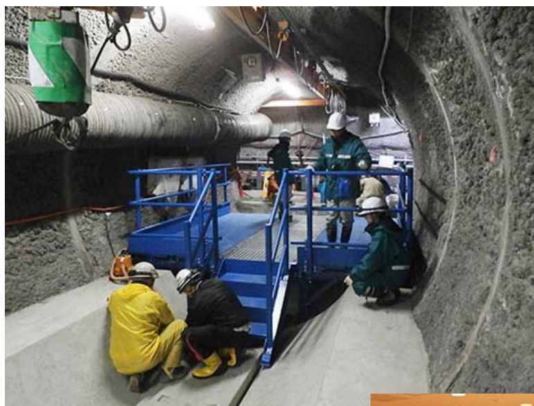
原環センター・原子力機構 共同研究 人工バリアの搬送定置・回収技術の実証試験にむけた試験坑道の整備の様子 （平成29年1月、 於 350m調査坑道）
