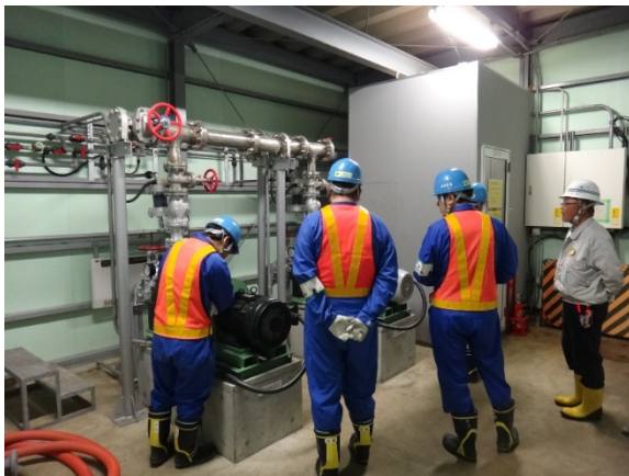
写真 14 安全パトロールの状況
