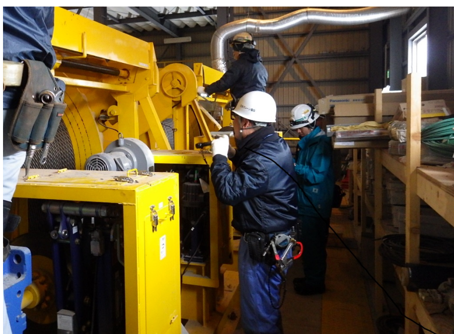
写真 6 地下施設の維持管理状況（機械設備の点検・整備）
